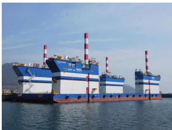
写真-1 完成全景
