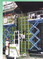
大型枠ユニット 取り付け機
