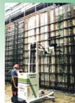
鉄筋ユニット 取り付け機
