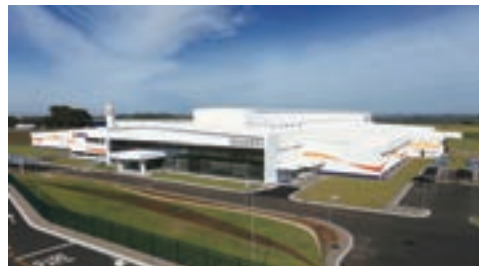
ユニチャーム ブラジル ジャグアリウーナ工場 (2014年竣工:ブラジル)
