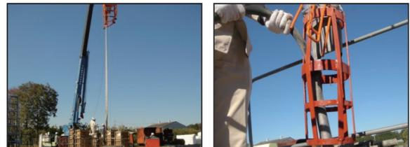
写真-1 打設状況および棒状パイププレート固定用治具の外観
