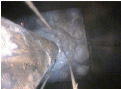
写真-2 鋼管内部のコンクリート打上り状況
