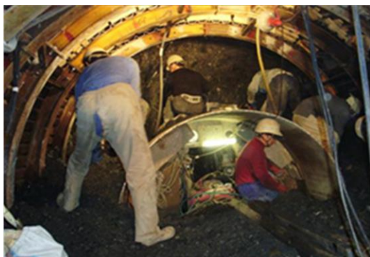
写真-1 TBM マシン周囲人力拡幅掘削状況
