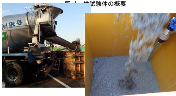
写真-2 柱試験体の打込み状況
