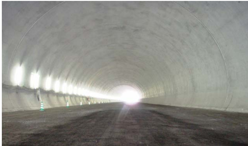
シムロック補強コンクリート施工によるトンネル完成写真
