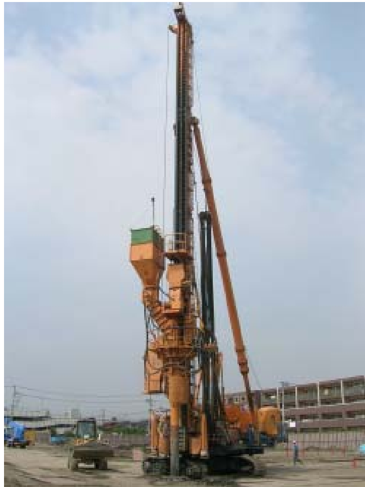
施工機械全景
