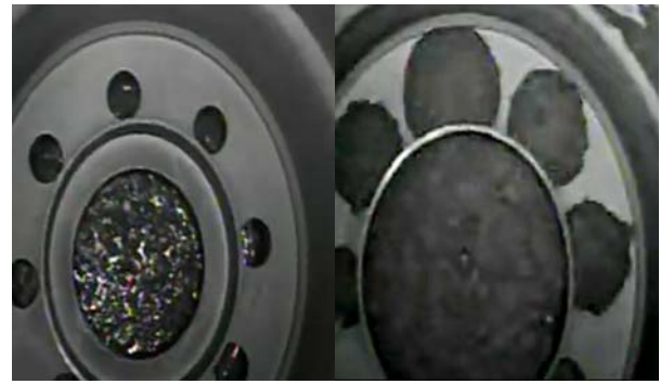
(a) 充填前 (b) 充填状況 図3 細柱 CFT による充填施工状況
