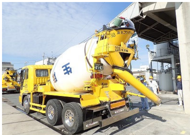
写真 4 硬化促進剤添加状況
