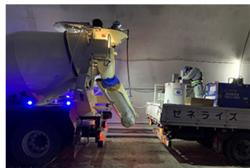
写真 1 硬化促進剤投入状況
