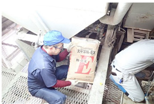
写真2 早強型膨張材投入状況
