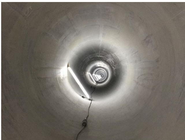
写真 5 二次覆工コンクリート打設完了
