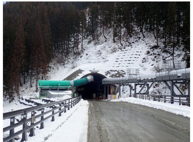
写真 6 トンネル坑口
