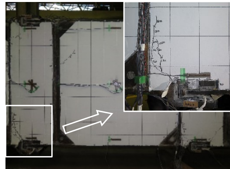
写真 4 ひび割れ発生状況
