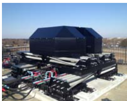
写真-2 AMDの外観
