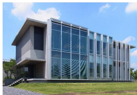
写真 - 1 実証建物外観
