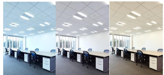
写真 - 3 事務室内の調光調色制御状況
