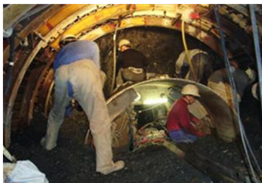
写真-1 TBM マシン周囲人力拡張掘削状況
