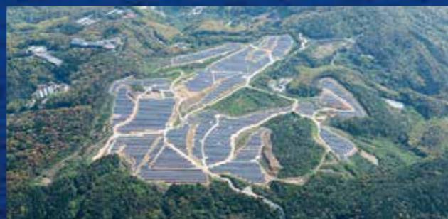
長崎田手原メガソーラー発電所
