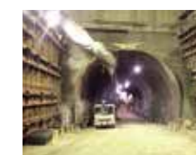
防音ハウス内のトンネル掘削状況
