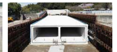
平成28年度 23号蒲郡BP豊沢道路建設工事 発注者:国土交通省中部地方整備局
