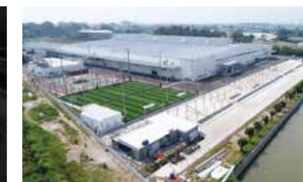
スタンレー第2工場増築工事[ベトナム] 発注者：ベトナムスタンレー電気(ベトナム戸田建設(有)施工)
