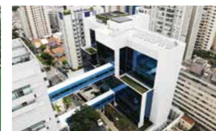
サン・カミーロ病院増築工事[ブラジル] 発注者：サン・カミーロ病院(ブラジル戸田建設(株)施工)
