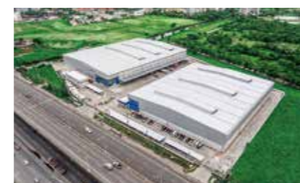
郵船ロジ倉庫新築工事[タイ] 発注者：郵船ロジスティクス(タイ)(タイ戸田建設(株)施工)
