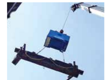
クレーンの吊荷旋回制御装置「ジャイアン」
