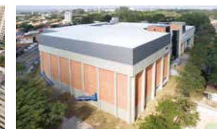
INPE宇宙開発機構研究所増築工事[ブラジル] 発注者：ブラジル国立宇宙研究所(ブラジル戸田建設(株)施工)
