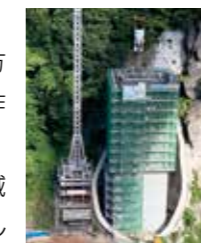
自昇式大型型枠足場 (SPU足場)
