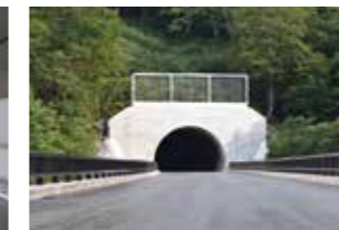
国道289号6号トンネル
