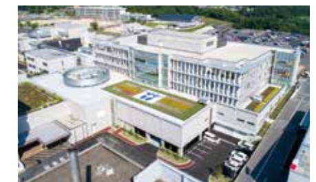
津山中央病院新病棟増築工事 発注者：(一財)津山慈風会
