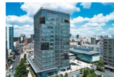
(仮称)北里研究所白金キャンパス 薬学部校舎・北里本館新築工事 発注者：(学)北里研究所
