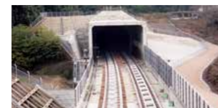
九州新幹線(西九州)、武雄トンネル外1箇所他 発注者:(独)鉄道建設・運輸施設整備支援機構
