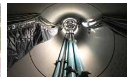
YCDCバゴー川横断配管工事[ミャンマー] 発注者：ヤンゴン市開発委員会(YCDC)
