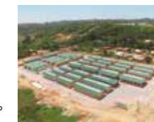
新設された中央市場全景
