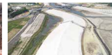
津谷川外河川災害復旧工事(その4) 発注者:宮城県
