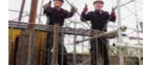
外国人技能実習生に対する助成(鉄筋)
