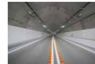
北海道横断自動車道 第二天神トンネル工事
