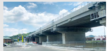
湯浅御坊道路 水尻高架橋他1橋 (PC上部工)工事
