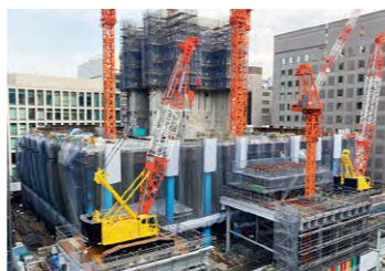
新本社ビル建替え工事の施工状況 (2023年6月30日)
