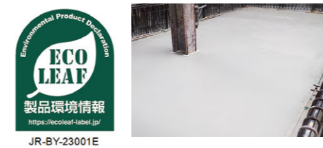
TODA BUILDING 耐圧スラブのスラグリート®70適用状況
