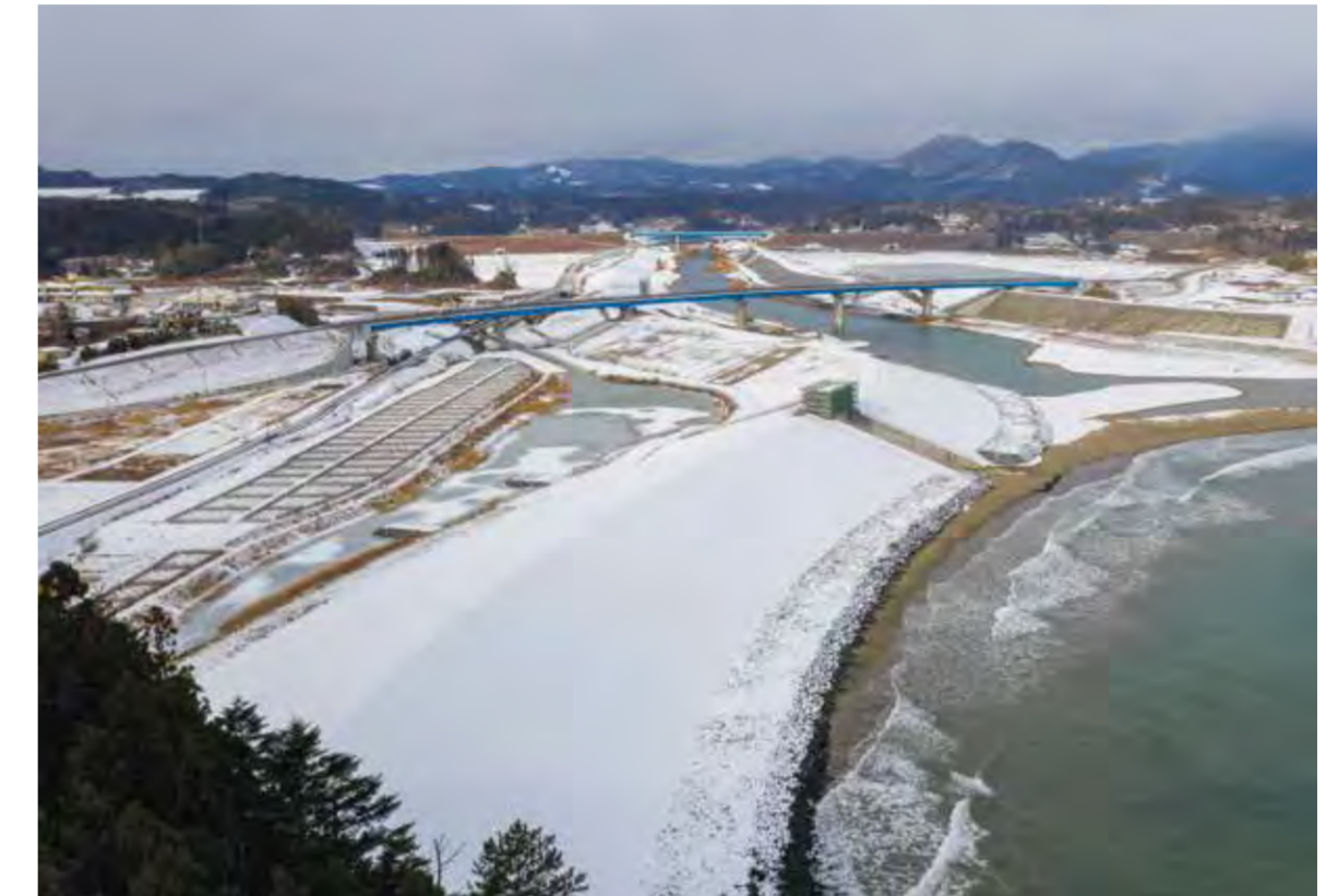
宮城県気仙沼市を流れる津谷川は河口から約4km上流まで津波が遡上し、道路や鉄道の橋も流されるなど大きな被害を受けた。戸田建設はその津谷川の堤防および防潮堤の復旧を手掛けた
