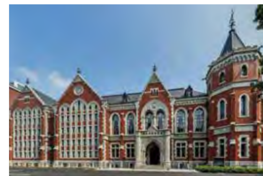
慶應義塾図書館旧館は創立50周年を記念して1912年に建てられたもの。歴史的価値のある建物を地震から守るために、2019年に完了した改修工事では基礎から上を免震化する免震レトロフィットが採用された
