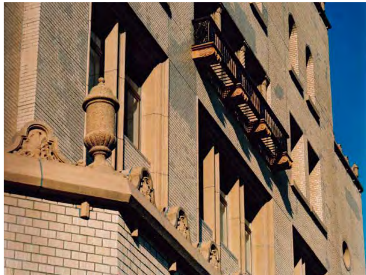
横浜税関は中庭を囲むロの字形平面で、西側部分を中心に増改築、公道に面する他の3面は補修して創建当時の意匠に戻した。塔のアーチ型窓の面格子は、痛みが激しく新たに製作した。内部の床や外部の塗装は、既存のものを生かしながら改修している
