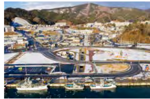
津波により大きな被害を受けた宮城県女川町。戸田建設はJR駅の再建を手掛けた
