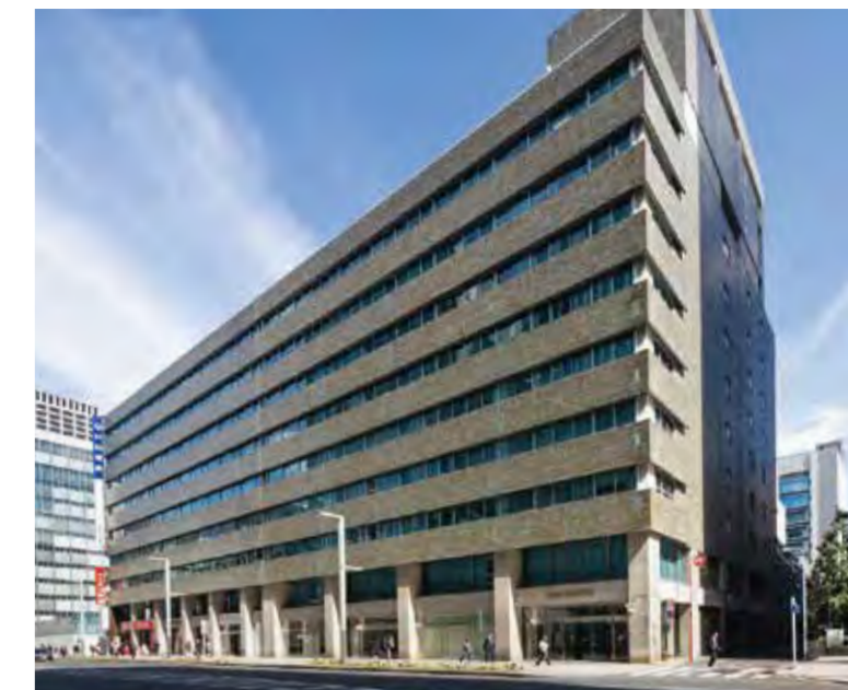
1961年と1966年の2期に分けて建設された本社ビル「新八重洲ビルディング」。2006年に「TODA BUILDING」に名称変更。2019年末から2020年にかけて解体された
