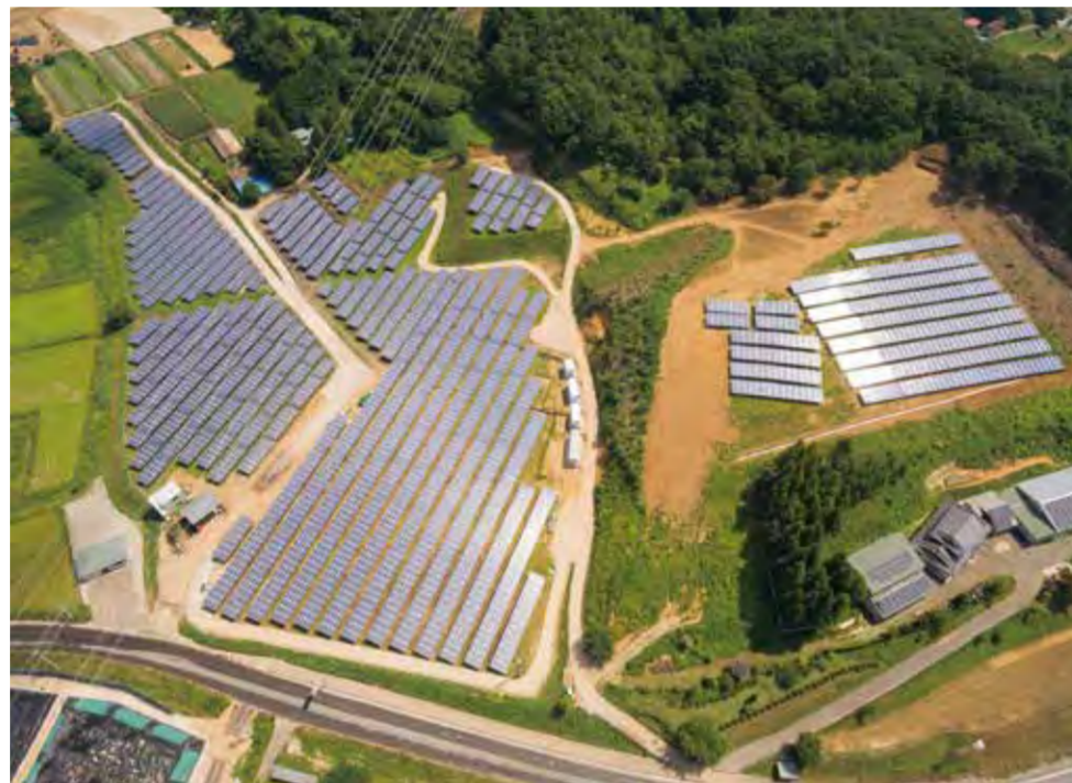
福島県川俣町の復興メガソーラー発電所。戸田建設は町などと共に事業者として運営まで関わる
