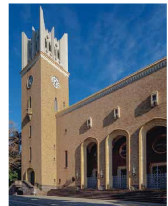
1927年完成の早稲田大学大隈記念講堂。大学の創立125周年に当たる2007年に大規模な改修工事が完了した。外壁のタイルは一部を除いて撤去して、元の素材から製法まで可能な限り忠実に再現して製作したタイルを貼った。鐘楼の外壁仕上げも撤去の上復原、笠木や窓台などもつくり直している
