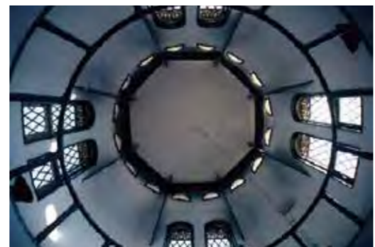
横浜税関は中庭を囲むロの字形平面で、西側部分を中心に増改築、公道に面する他の3面は補修して創建当時の意匠に戻した。塔のアーチ型窓の面格子は、痛みが激しく新たに製作した。内部の床や外部の塗装は、既存のものを生かしながら改修している
