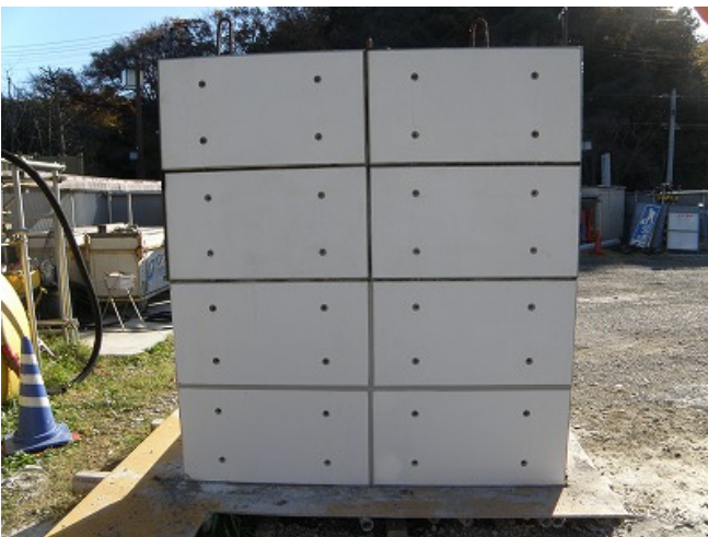
写真-7 モデル施工試験（埋設型枠工法）施工完了
