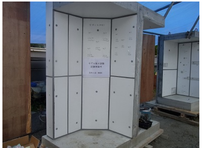
写真-6 モデル施工試験（型枠工法）施工完了
