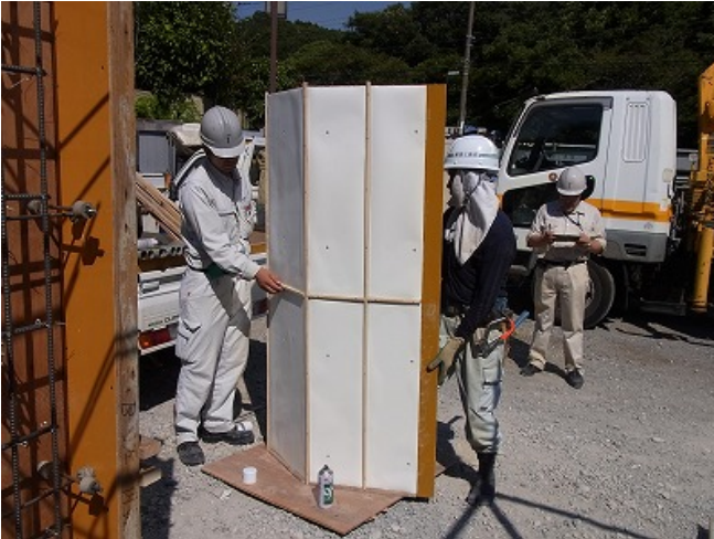
写真-3 型枠へのシートの仮固定
