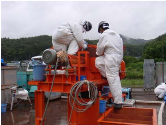
写真1 特殊洗浄機による洗浄状況
