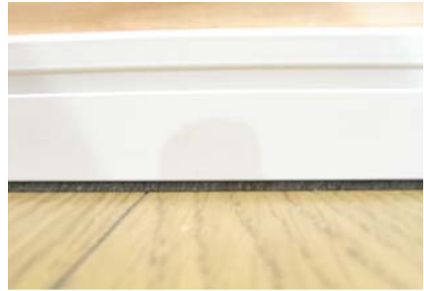
写真2 システム巾木Mの設置状況
