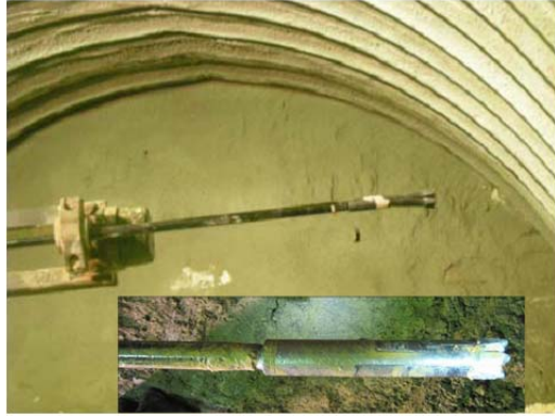
【拡縮径ビット装着状況】
