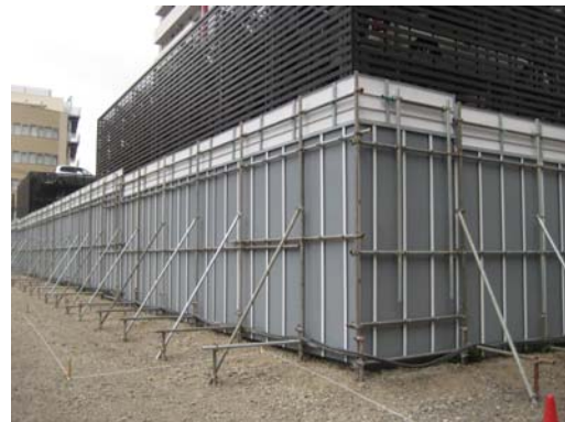
写真2 建設現場適用状況
