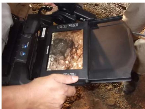
写真1 DRi スコープによる調査状況
