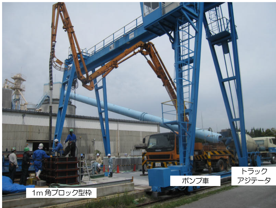
写真-2 ポンプ車を用いた打込み試験状況
