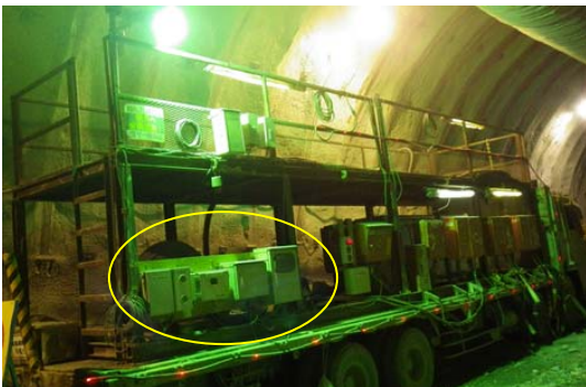
写真1 自動計測状況（計測機器全景）
