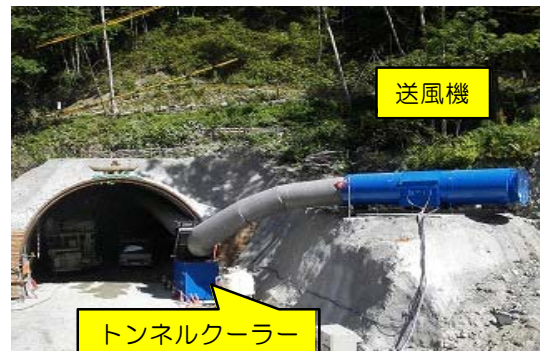
写真2 送風機自動稼働状況
