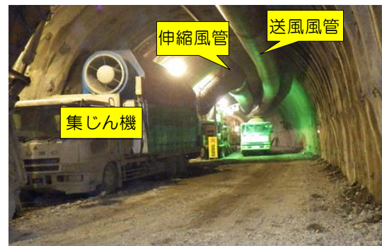
写真4 集じん機自動稼働状況
