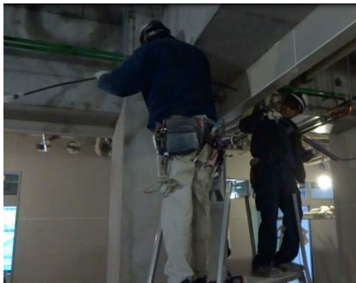
写真1 LCX施工状況
