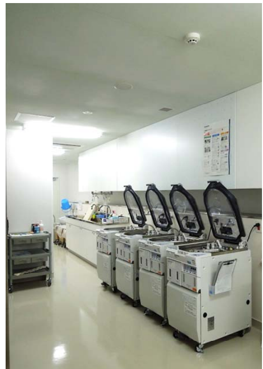
写真2 ゼオライト消臭塗料を塗装した天井（内視鏡洗浄室）
