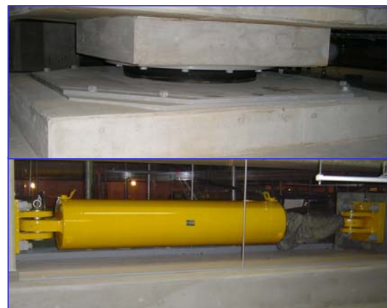
写真2 TO-HIS工法（上：弾性すべり支承） （下：オイルダンパー）
