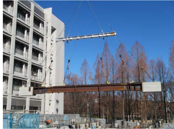
写真 4 T0-RCSB 構法 (T0-RCSB 梁)
