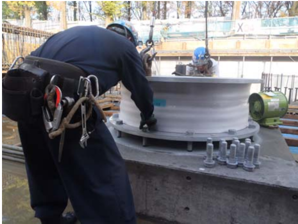
写真 1 T0-HIS 工法 (積層ゴム取付状況)
