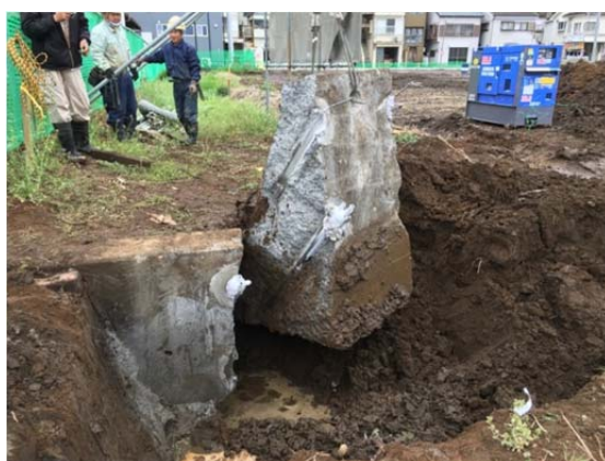
写真2 解体した擁壁の撤去状況
