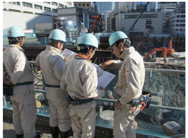
山留・掘削工事の説明を受ける生徒(中央2名)
