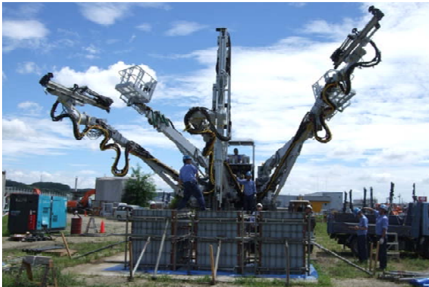
写真-1 模擬地山による基礎実験状況 (ガイドセル部を改良したドリルジャンボ)
