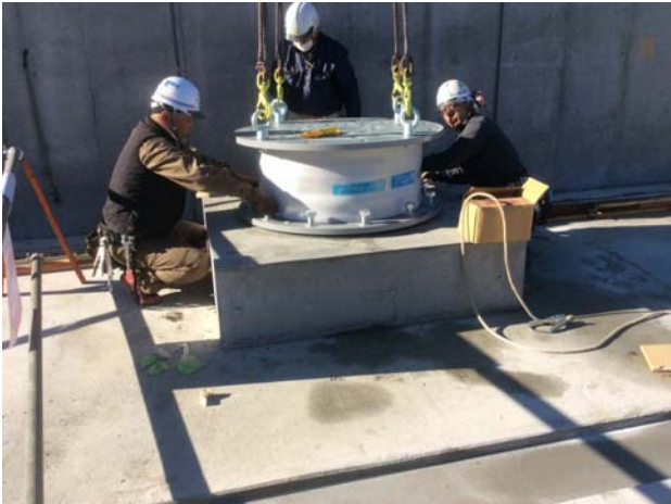
写真1 T0-HIS 工法（積層ゴム取付状況）
