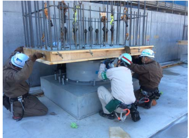
写真2 PCa 免震基礎取付状況
