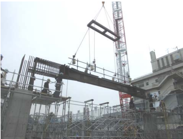
写真3 T0-RCSB 構法（T0-RCSB 梁取付状況）
