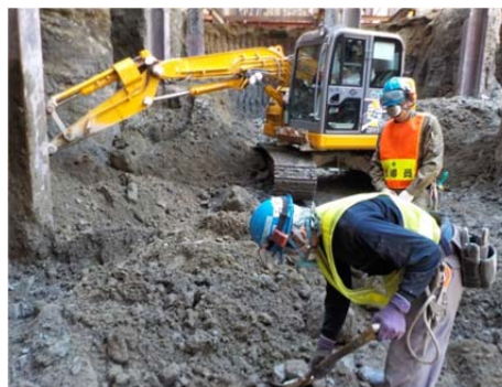
写真2 作業員と重機の近接作業状況-2
