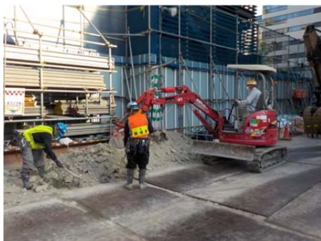
写真1 作業員と重機の近接作業状況-1
