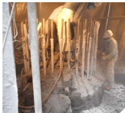
写真3 一般のハンドブレイカーによる解体状況(従来工法)
