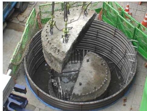
写真2 余盛コンクリート撤去状況
