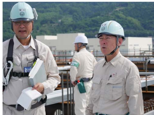
写真2 作業場所の安全点検
