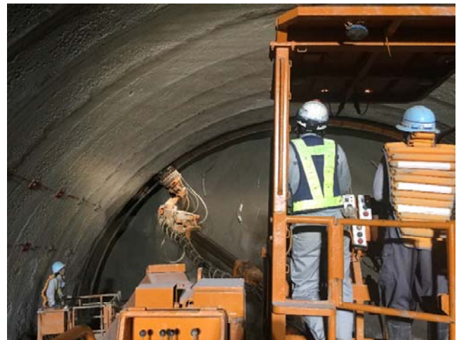
写真-2 鉄矢木の打設状況
