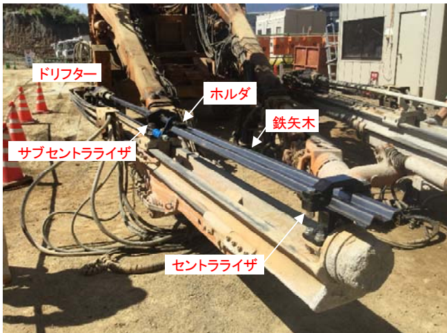
写真-1 鉄矢木打撃装置の装着状況
