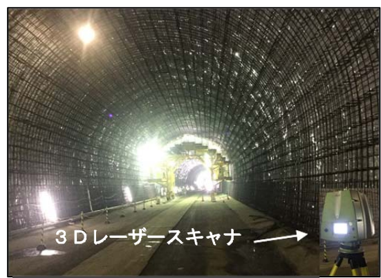
写真1 3Dレーザースキャナによる計測状況
