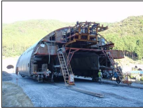
写真2 セントル全景
