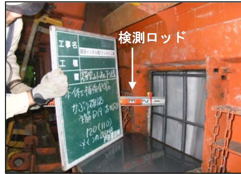
写真3 従来のかぶり厚さ計測状況 (セントルの検査窓から計測)
