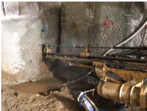
写真-4 試験施工（穿孔状況）
