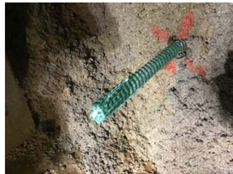
写真-3 従来品端部の破損状況
