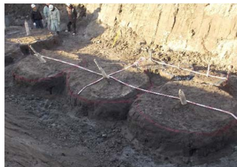
改良体出来形（新工法B）
