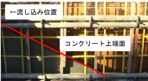
(a) 流動化前 (バイブレータ有り)
