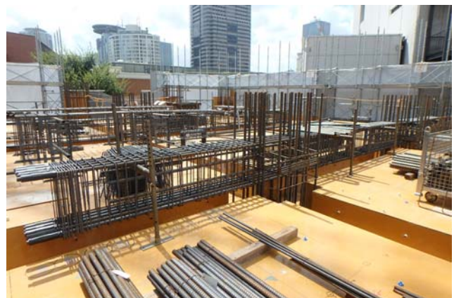
写真1 梁配筋状況
