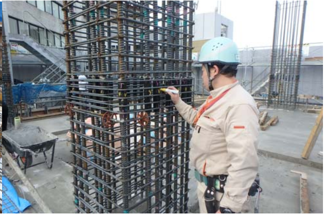
写真3 柱主筋継手検査状況
