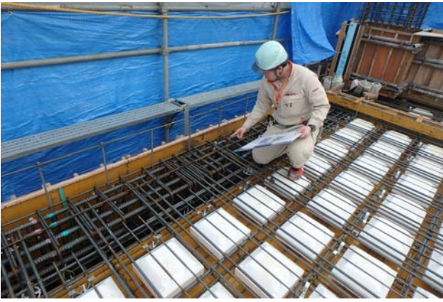
写真2 梁配筋検査状況
