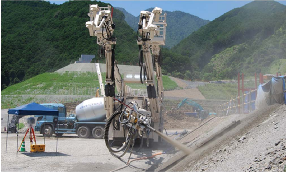
図-1 実証実験状況
