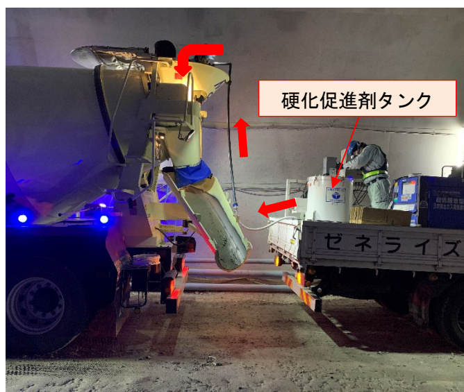
写真-2 現場添加状況
