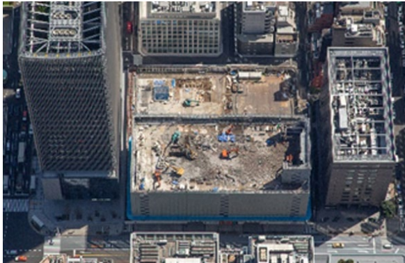
解体の工事全景
