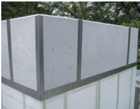
エッジサイレンサー設置状況
