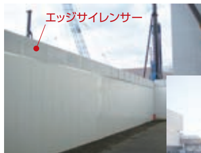
建設工事現場への適用例
