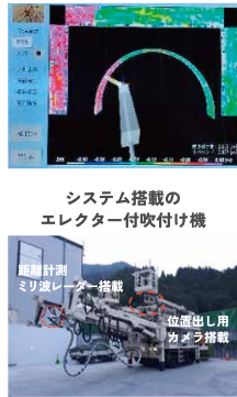
リアルタイム出来形表示状況 (赤表示:吹付け済)
