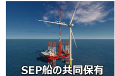
五島市沖洋上風力発電事業
