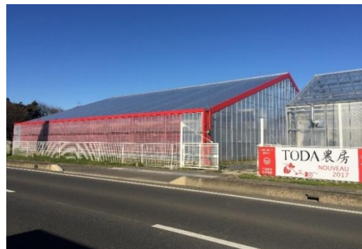
写真1 スリークォータ型屋根が特徴的な高採光型温室の外観
