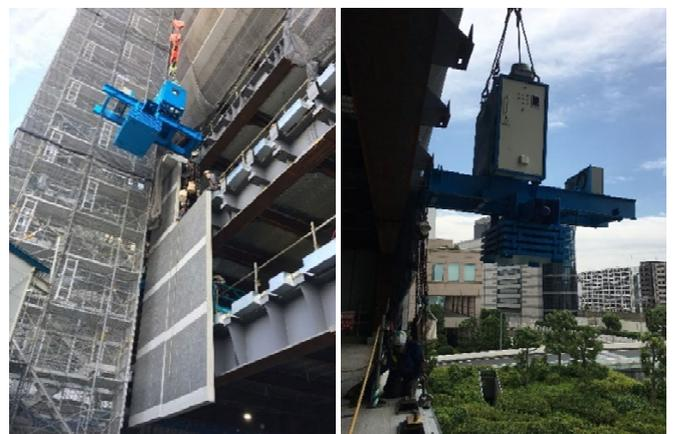
図 17 バランサー使用状況
