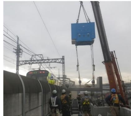
図 14 営業線列車走行時の架設状況
